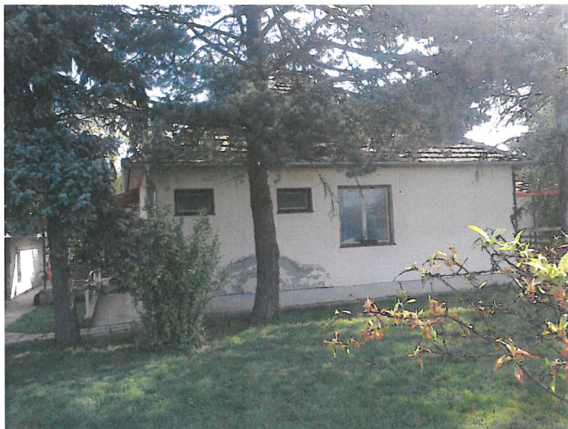
A hátsó homlokzat és a vizesblokk szigetelési hiánya
