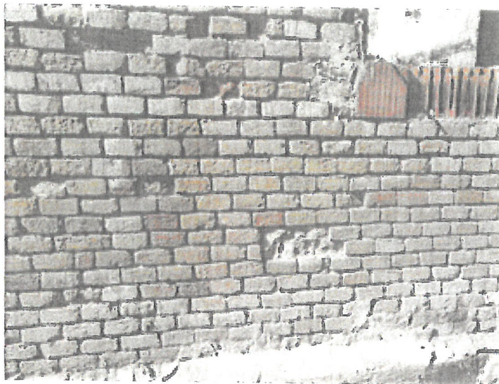
6. ábra. É-K-i fal külső oldalán több helyen megbontott fal
